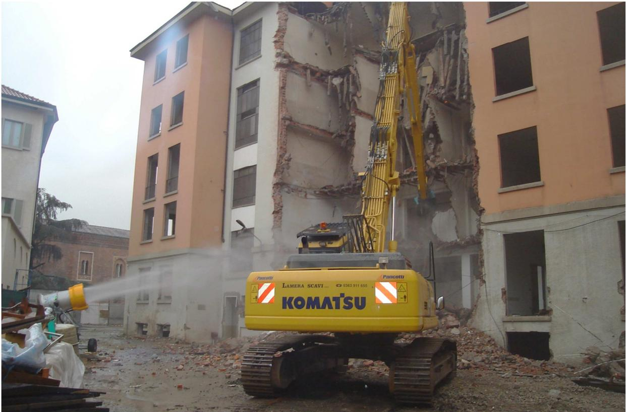
Figura 3 Abbattimento polveri con cannone nebulizzatore
