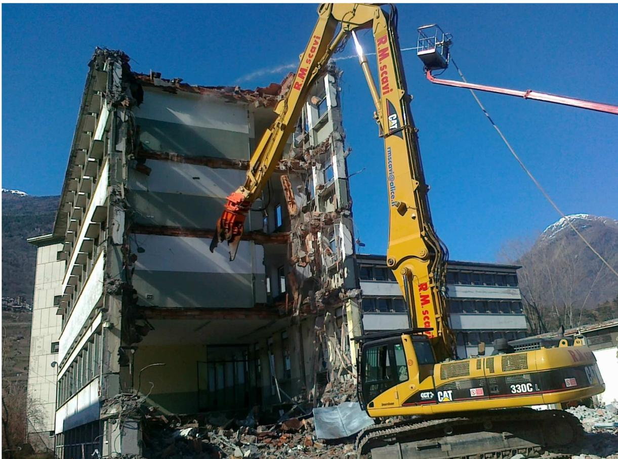
Figura 2 Demolizione primaria con escavatore con braccio da demolizione
