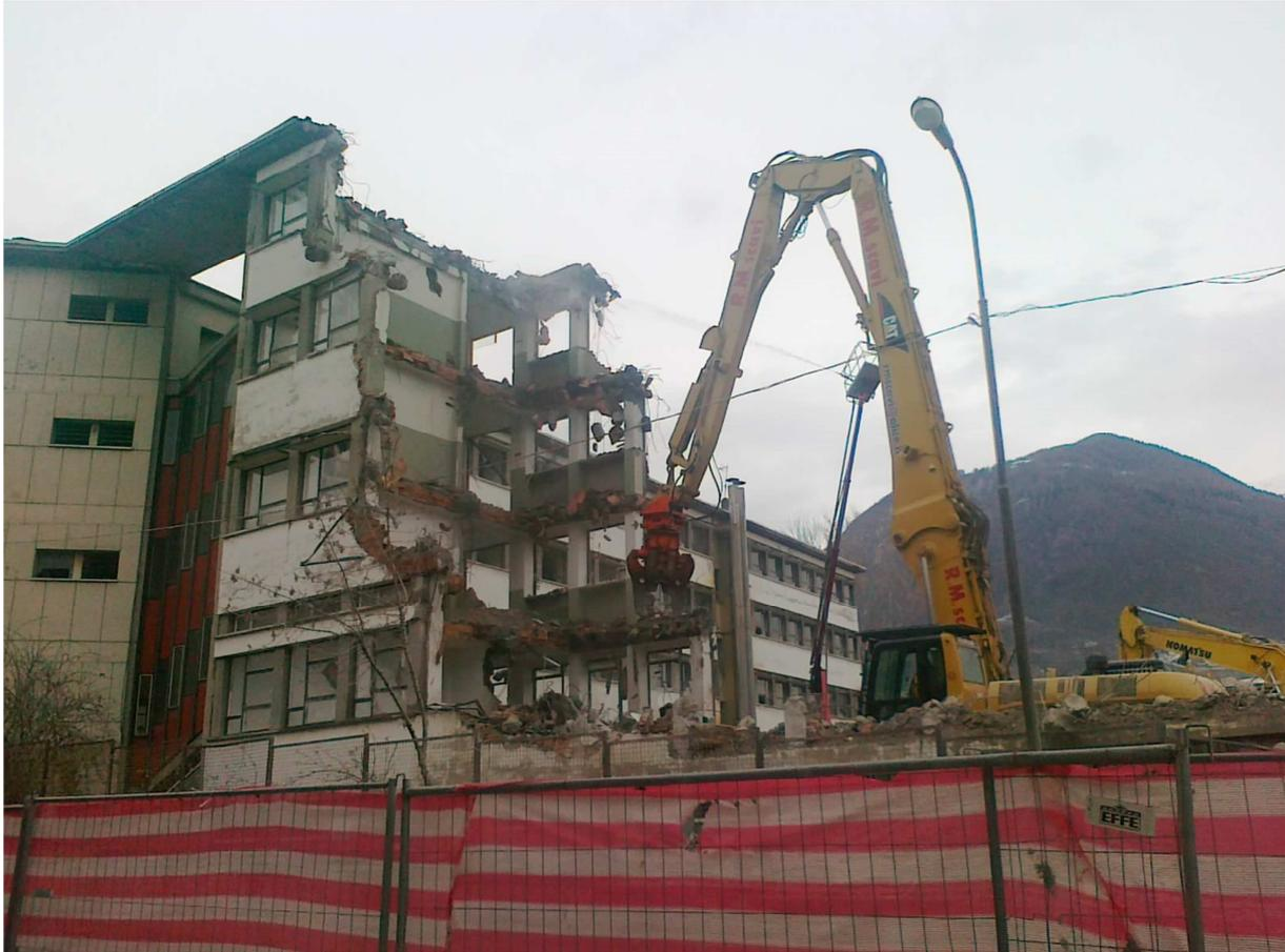
Figura 1 Demolizione primaria con escavatore con braccio da demolizione
