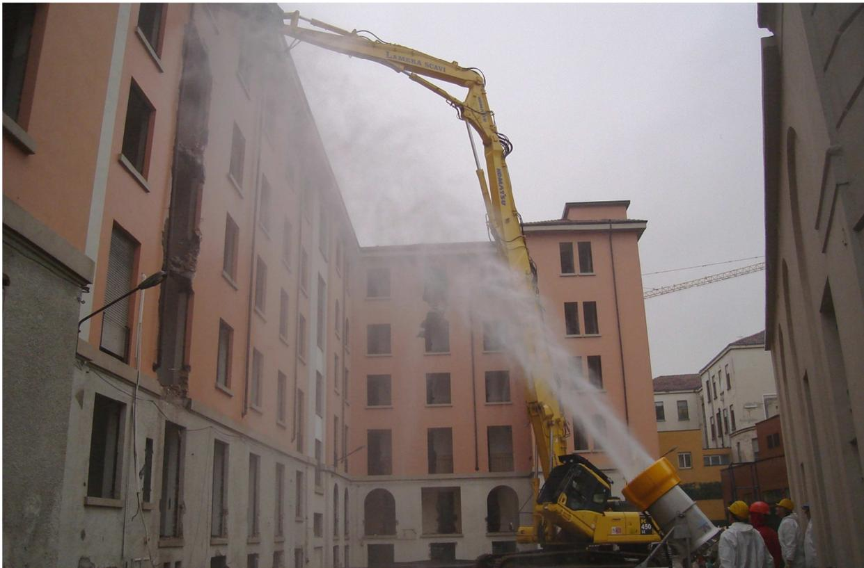
Figura 4 Abbattimento polveri con cannone nebulizzatore
