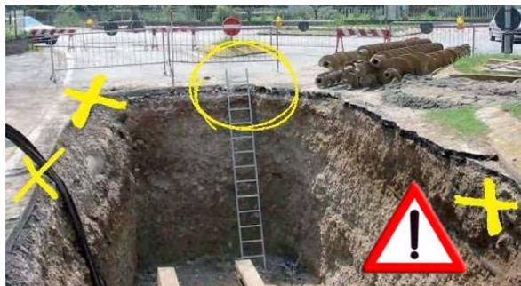
Fronte scavo verticale, profondo più di 1,5 mt senza protezioni contro la frana e caduta di lavoratori dentro lo scavo, la scala è troppo corta e non sporge in maniera sufficiente dallo scavo ed inoltre non è fissata.
