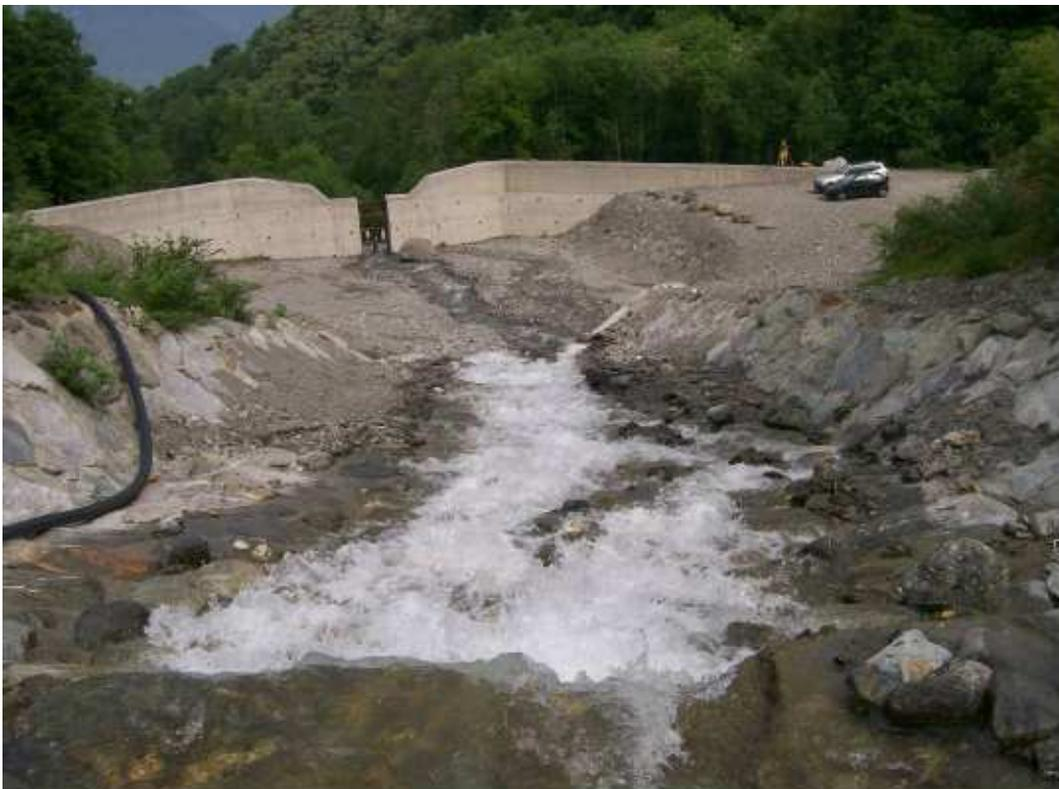
**Figura 2 – Briglia selettiva a fessura e vasca di accumulo in località Navascia (513 m s.l.m)**
