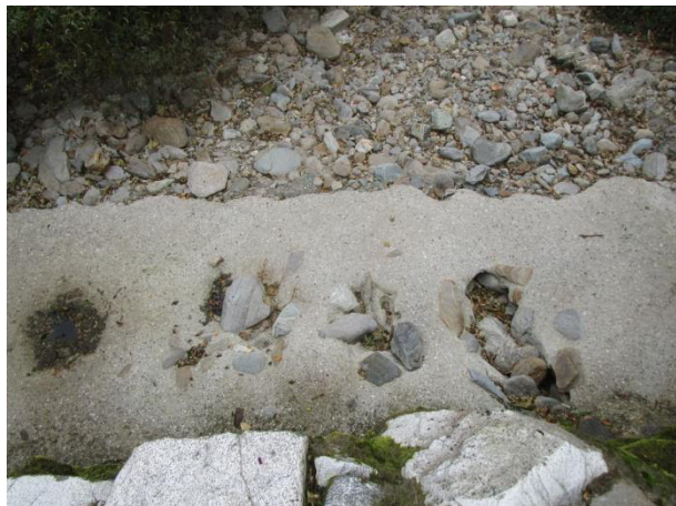
Vista del selciato a valle della soglia B20 (sinistra) e del cedimento di quello in corrispondenza dello scarico del guado presso la soglia B21 (destra)
