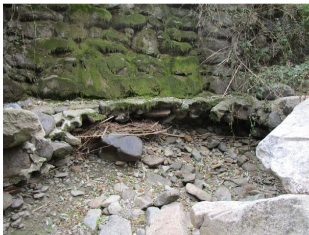
Vista dello scalzamento al piede della soglia B18 nella sua parte terminale(sinistra) e di quella iniziale a valle del primo salto (destra)
