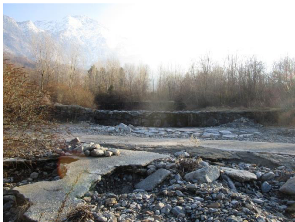
Vista della pavimentazione in pessimo stato di manutenzione nella porzione di valle del guado e vista della tubazione libera da depositi di qualsiasi genere in data 26 Ottobre 2018
