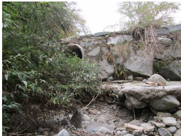
Vista del selciato a valle della soglia B20 (sinistra) e del cedimento di quello in corrispondenza dello scarico del guado presso la soglia B21 (destra)
