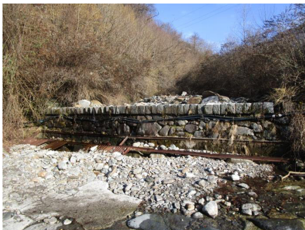
Vista della briglia B35 a monte del guado e particolare della griglia divelta
