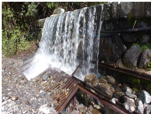
Vista della briglia B35 a monte del guado e particolare della griglia divelta
