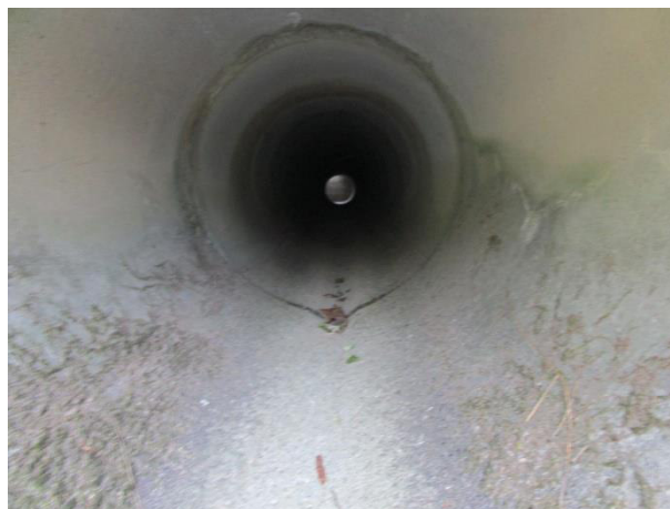
Vista della pavimentazione in pessimo stato di manutenzione nella porzione di valle del guado e vista della tubazione libera da depositi di qualsiasi genere in data 26 Ottobre 2018
