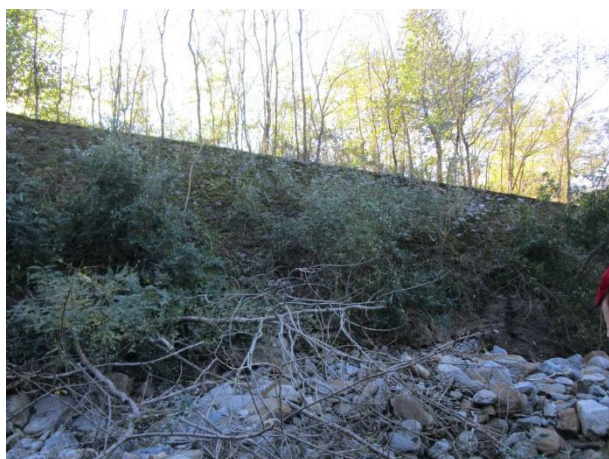
Vista dell'erosione al piede del muro d'argine in sponda sinistra e particolare al piede
